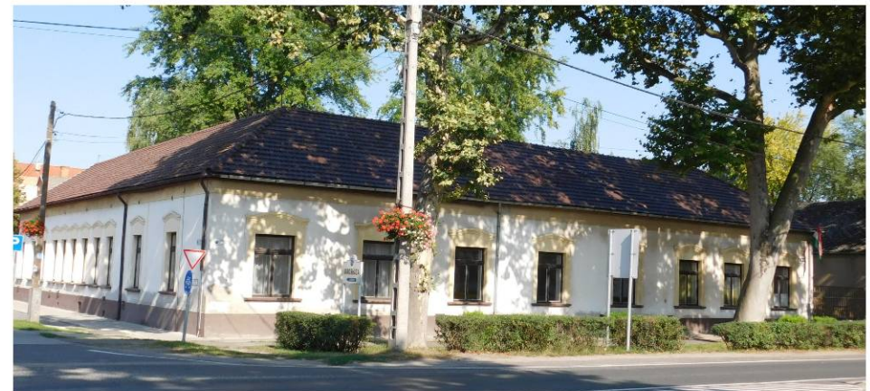
A „Sury-iskola” arányos, vakolatdíszes homlokzata
